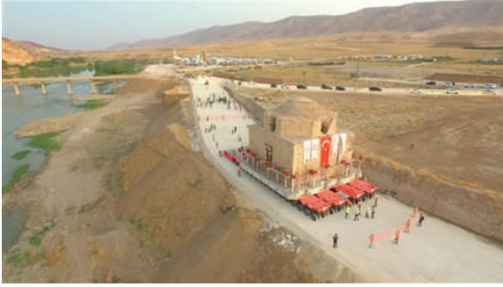
Şekil 1: Artuklu Hamamı'nın taşınmasına ait fotoğraf
